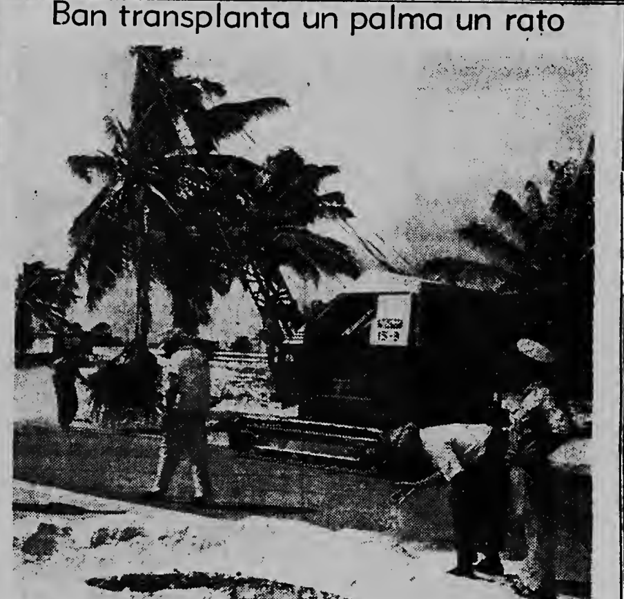
Ban transplanta un palma un rato Ayer mainta Sr. Kemmink cu ayudo di diesdos assistente, un bulldozer y un winchi y truck di awa a cumenza cu cambia lugar di como binti palma cu ta para den caninpa pa trahamento di e hotel. Di acuerdo cu e metodo di Miami y trabao a bai asina: e bulldozer a yuda caba, e winchi a hiza e mata cu raiz y tur for di den terra y a hibeles despues na un buracu hundo, cu mientras tanto cu forza di man tabata caba; nan a planta e mata el den y despues a basha santu riba e ralzaa mientras cu e truck di awa tabata basha awa tur cu tin. Y si acaso e palma tabata para un algo skeints awa e winchi tabata pushe un tiki! Mas adilanti e winchi ta corre yegando cu un dje palnanan: Sr. Kemmink ta inspecta atrobe pura si e buracu dilanti ta bon.
